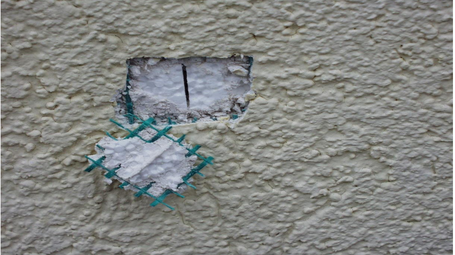
Armierungsmörtel in der Fuge
