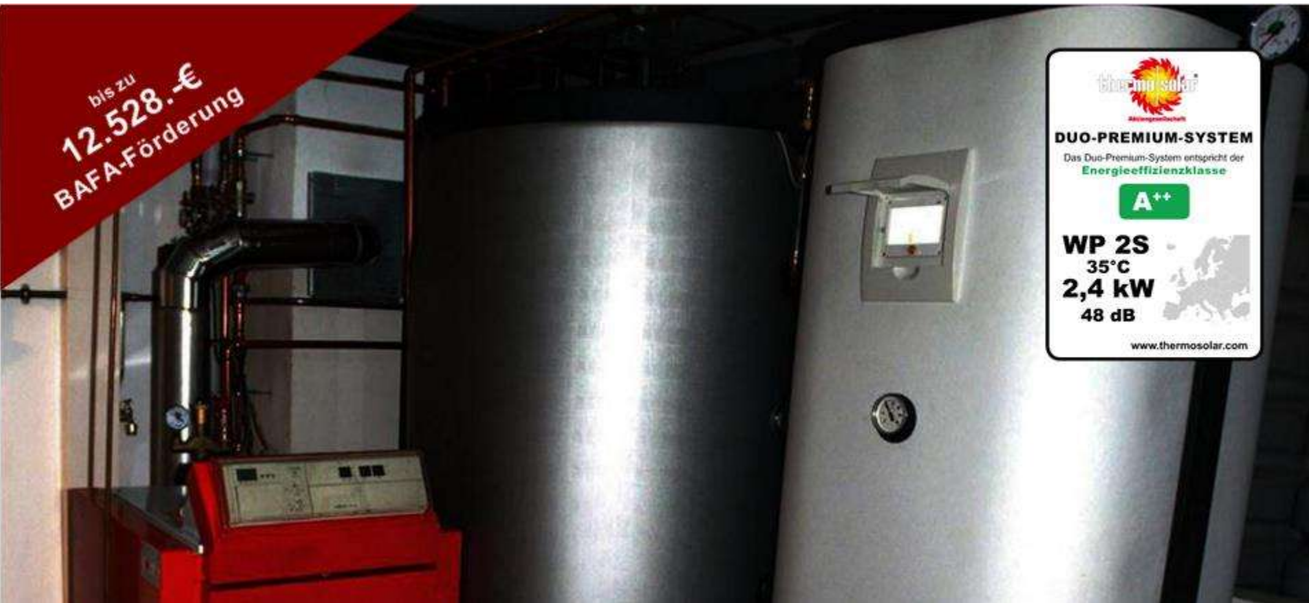
Grundlast Mini-Wärmepumpe (Solarthermie) + Spitze alter Kessel
