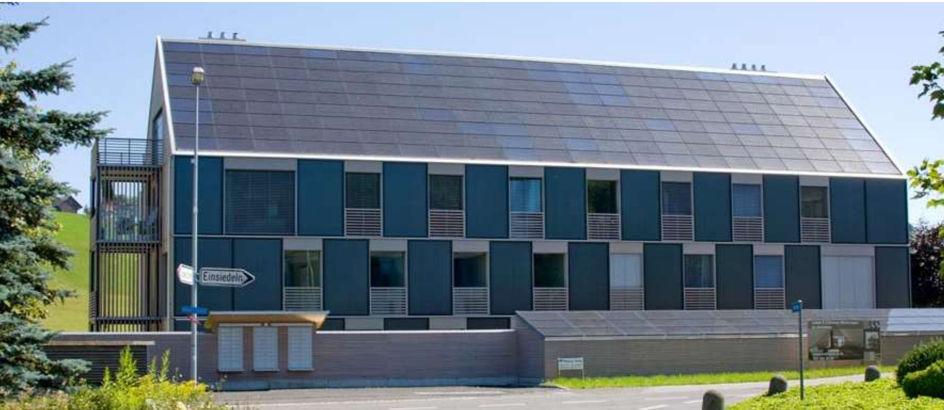
Kraftwerk B, Bennau
