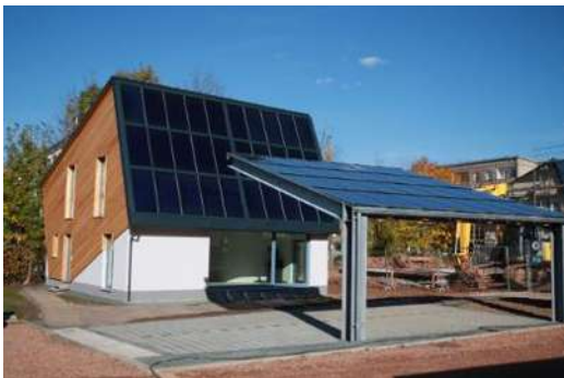
Foto: FASA AG
