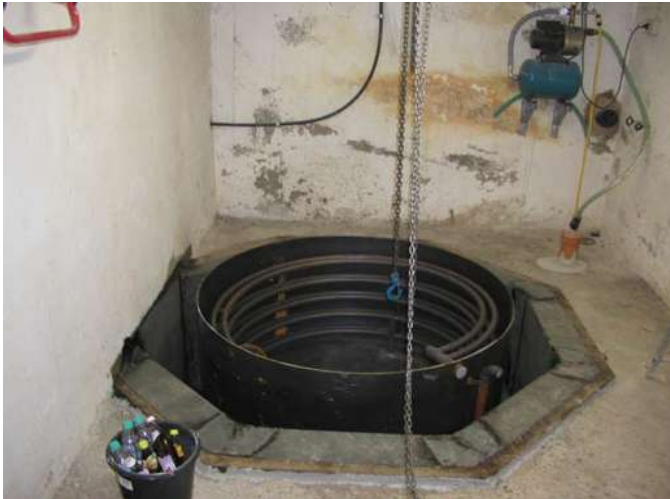
Solarspeicher - Kellerschweißung vor Ort
