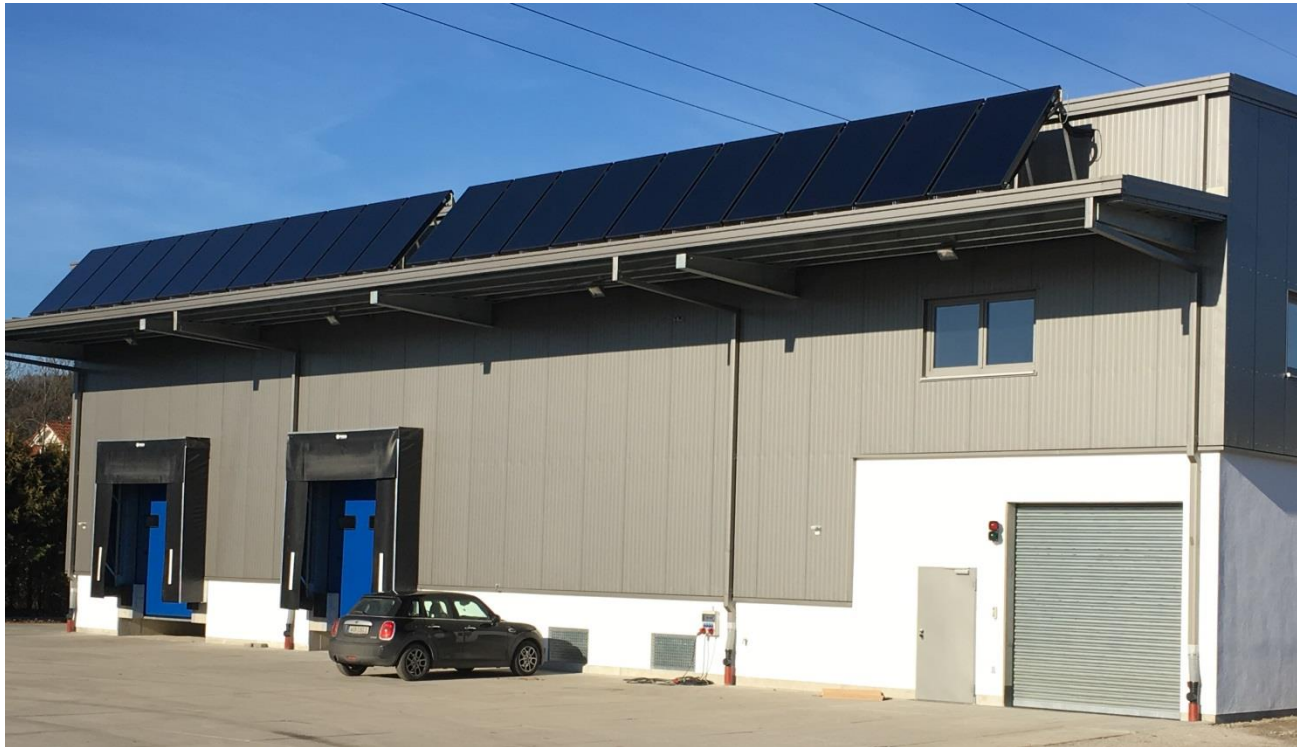
Spedition/Lagerhalle Frostfreihaltung Kollektorfläche: 51,6m 2 Deckungsrate seit letztes Jahr November: 100%
