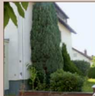
Bepflanzungen an der Fassade sollten regelmäßig zurückgeschnitten werden.
