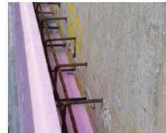
**Bild 1.2:** Nachdem die Bewehrung am aufgerauten Bestand angebracht ist, kann die Perimeterdämmung montiert werden. Diese wird geklebt und zusätzlich gedübelt (z. B. mit Termoz BU/305).
