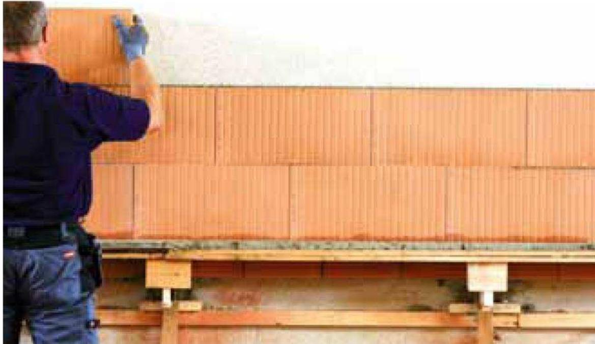
**Bild 4.7:** Auf dieser Konstruktion wird nun die wärmedämmende Vorsatzschale aus POROTON®-WDF® errichtet.
