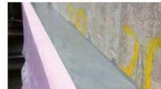
**Bild 1.3:** Mit Vergussbeton oder fließfähigem Normalbeton (≥ C20/25) wird nun der Ortbetonbalken als Aufstandsfläche für POROTON®-WDF® erstellt. Die Vormauerung muss mindestens zur Hälfte auf der Betonfläche aufliegen. Die Perimeterdämmung dient als verlorene Schalung.
