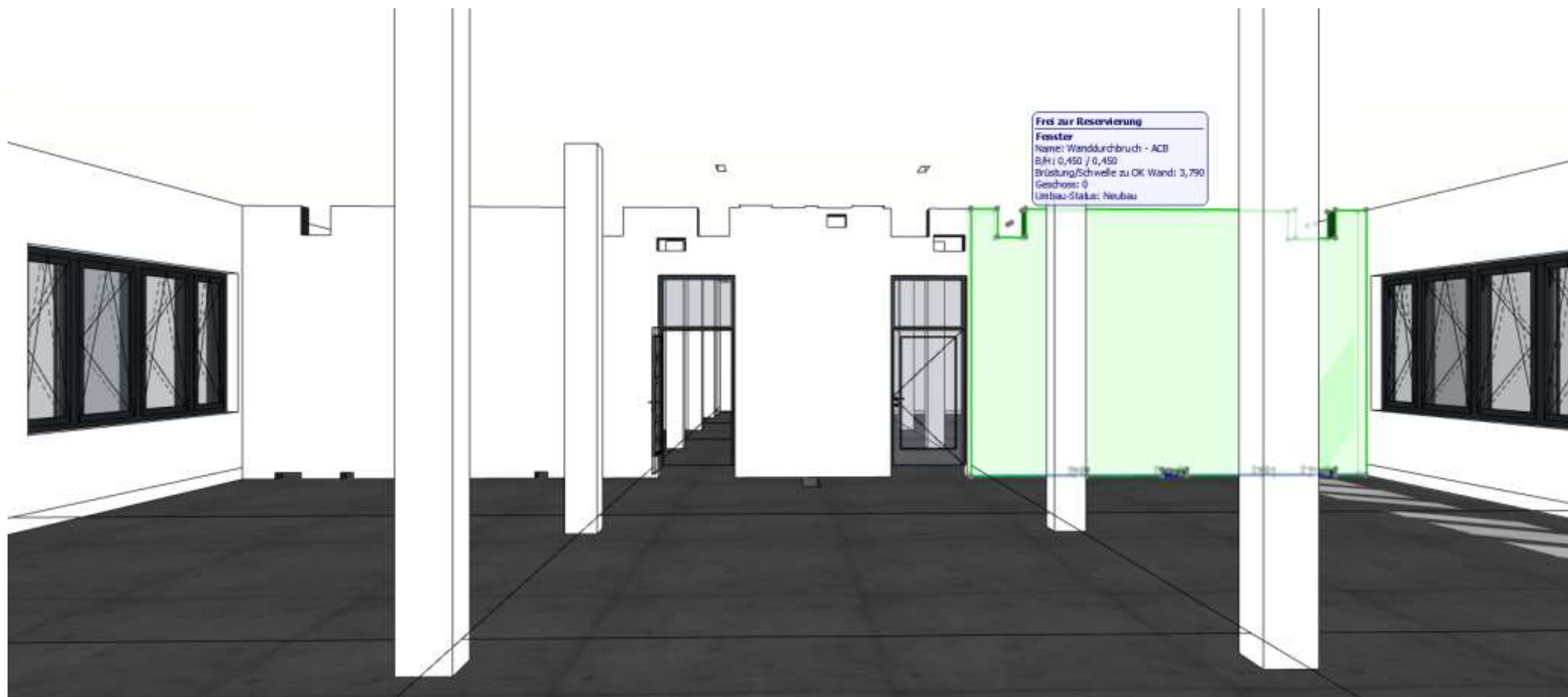
HAUS B11 –Modellsicht Mittelzone _Rohbau
