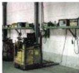
Die Temperaturen von Batterieladerräumen und -stationen sollten außerdem zwischen + 10 °C und max. + 25 °C liegen und die Lagerung und Aufstellung frostfrei sein.
