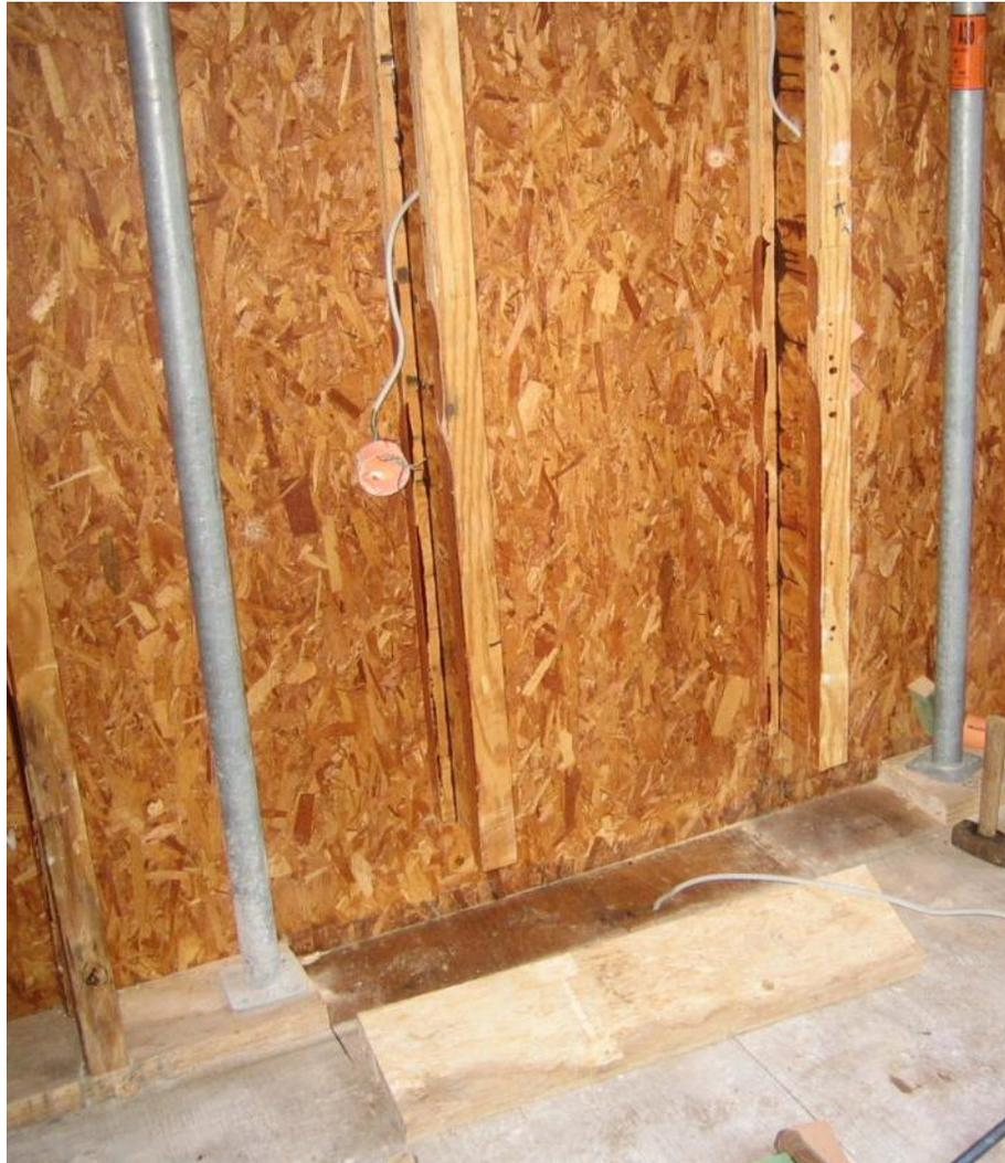
Probeweise Entfernung von OSB-Bodenriegel und 2 Doppelstegträgern nach statischer Sicherung der beiden Außenwände (Abstimmung und Abnahme durch Statiker)
