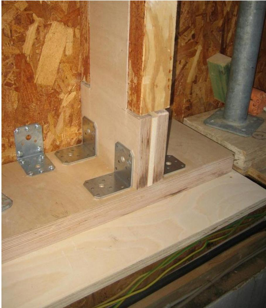
Fixierung der ergänzten Konstruktionsteile durch Zimmermannswinkel laut Abstimmung mit dem Statiker.
