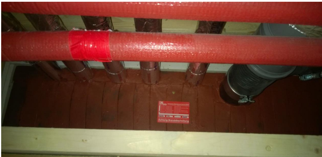
Bild J-II – 1: (Bild 7) Bauteilöffnung mit Brandschutzbekleidung nach Abschnitt 3.2 zum Einbau von Türen Fenstern und sonstigen Einbauten nach Abschnitt 3.5, Darstellung der Ausführung mit Fugenversatz
