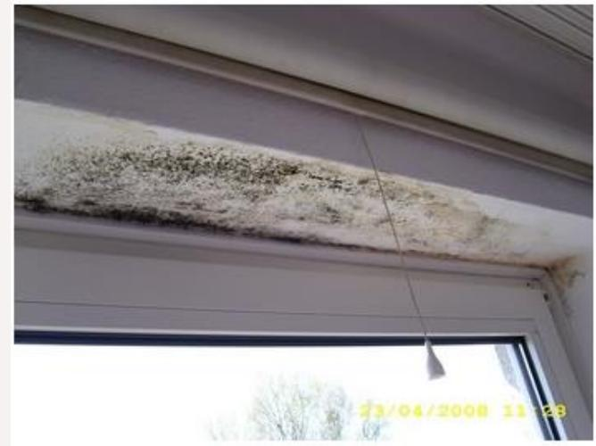
**Schimmelpilzschaden im Wohnungsinnenraum. Fehler hier: Lüften über gekippte Fensterstellung; Sturz kühlte ab, so dass Innenraumluft hier kondensierte.**
