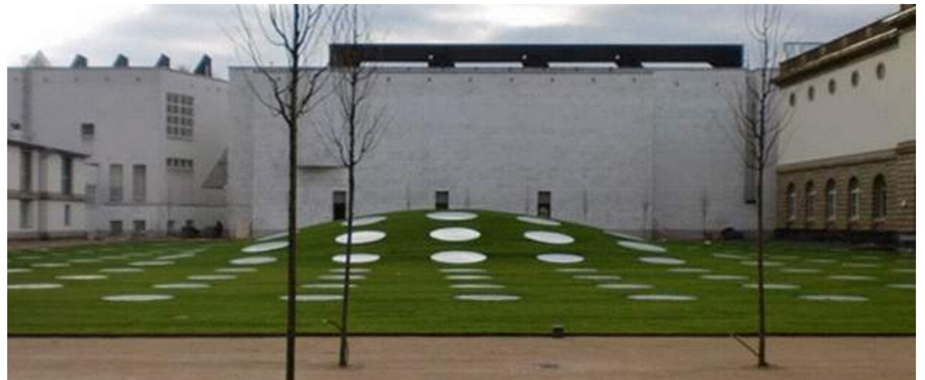
Dachbegrünung Stadel FFM (© Keller & Keller Landschaftsarchitekten)
