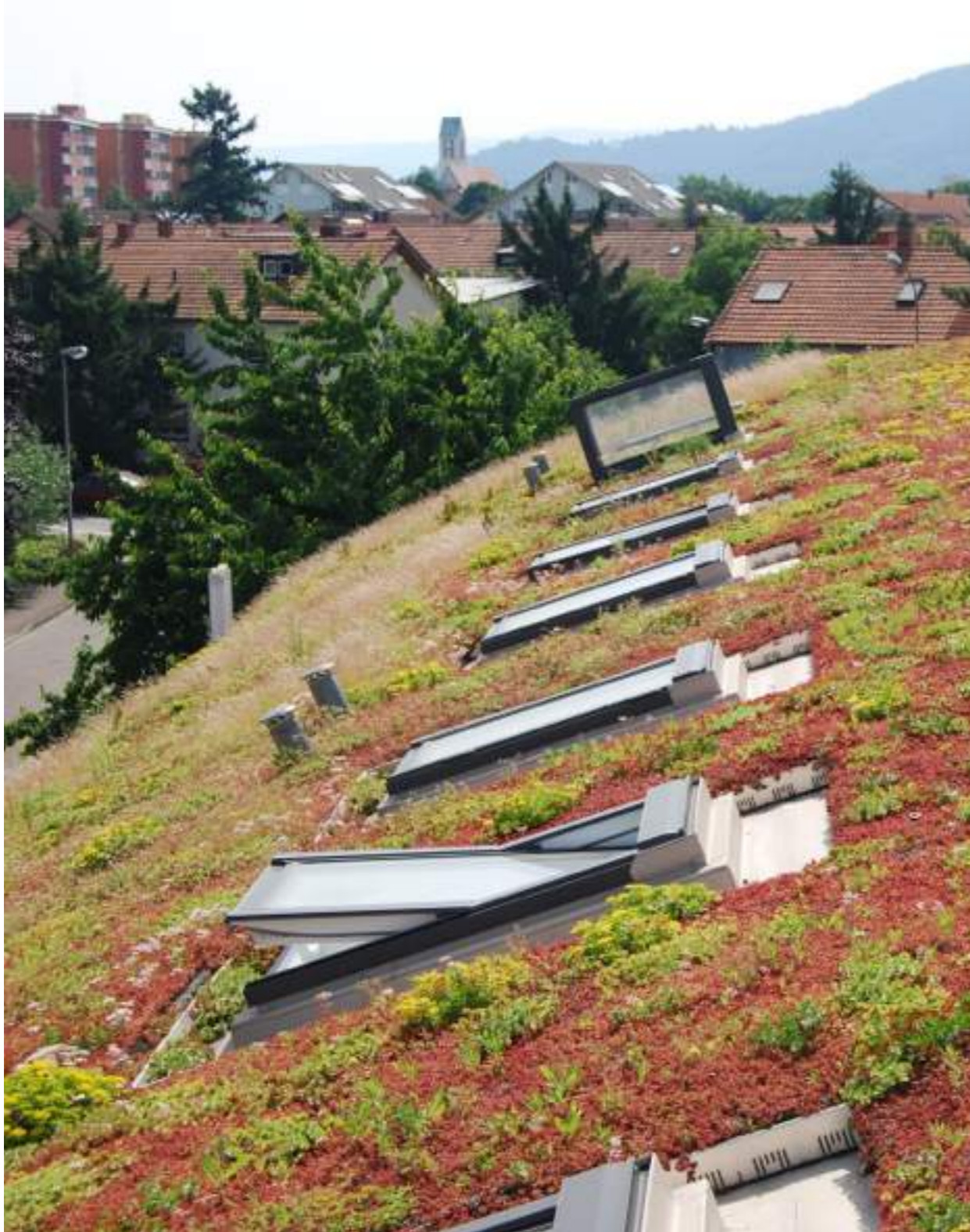
Bilder links und rechts: Kühlung der Gebäudeoberfläche durch Dachbegrünung (© Optigrün)
