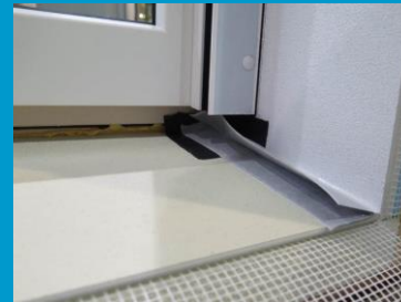
Vorgeputztes, gedämmtes Fensterleibungselement mit 2. Eckabdichtung
