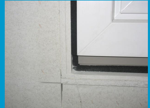
Gekapselte Leibung mit versetzten Stoßfugen
