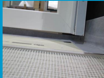
Eckabdichtung hinten und seitlich.
