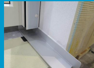
Gleitabschluss Duo, verklebt und oben verfugt. Auf diesem Gleitabschluss Duo wird die Sohlbankschiene verlegt.
