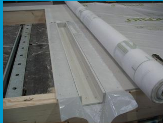
Einbau eines gekapselten Installationskanales
