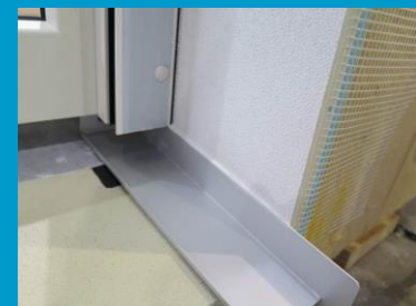
Gleitabschluss , verklebt und oben verfugt. Auf diesem Gleitabschluss wird die Sohlbankschiene verlegt.
