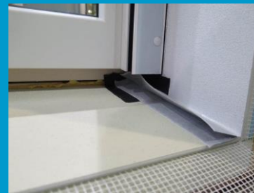
Vorgeputztes, gedämmtes Fensterleibungselement mit 2. Eckabdichtung
