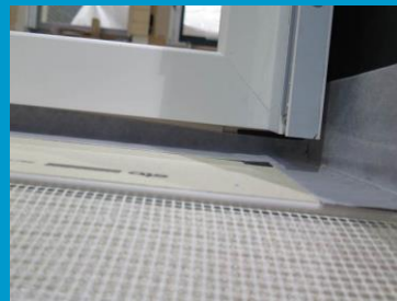
Eckabdichtung hinten und seitlich.
