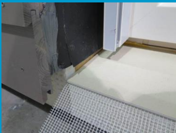
Vorgeputzte, keilförmige Dämm-UK unter der Sohlbank als 1. Dichtebene.
