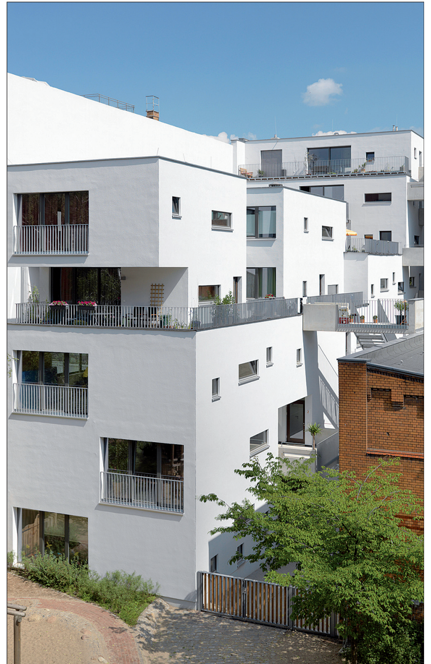
Neubau eines Familien-, Bildungs- und Gesundheitszentrums in Berlin, siebengeschossig in Holzbauweise. Architekt: Tom Kaden Foto: Bernd Borchardt
