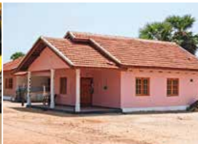
Eines der 70 errichteten Häuser
