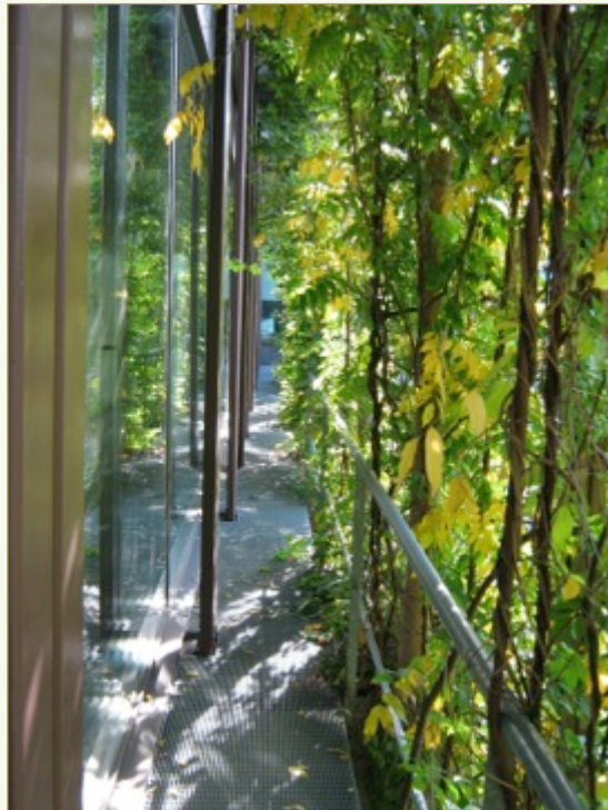
Kombinierte boden- und wandgebundene Fassaden- begrünung mit Kletterhilfen und Trögen
