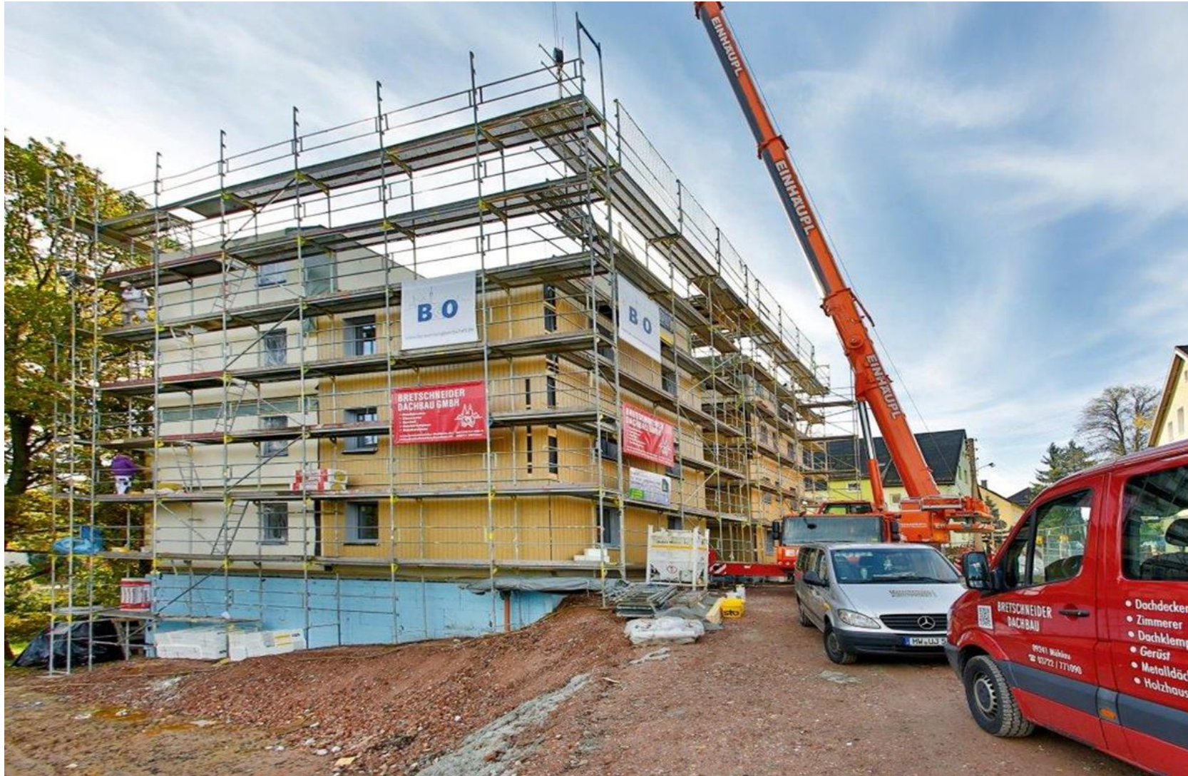
Holzbau: Bretschneider / Mühlau
