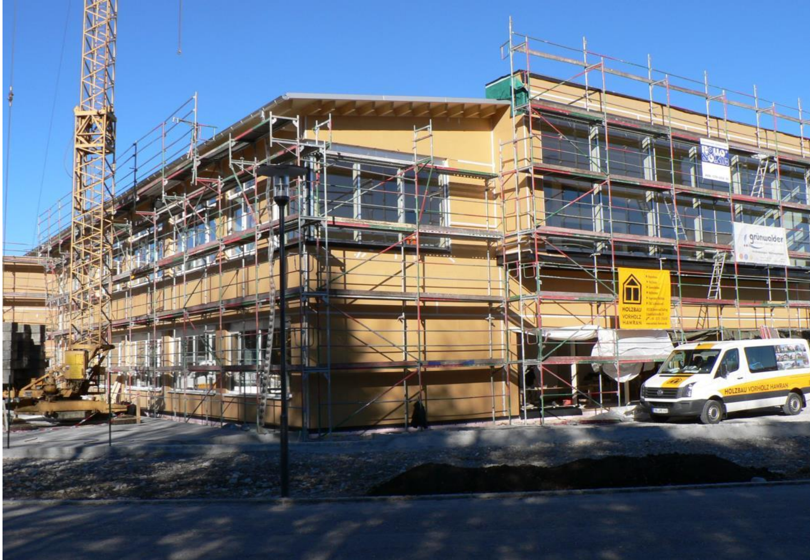
Holzbau: Vorholz Hawran / Geretsried
