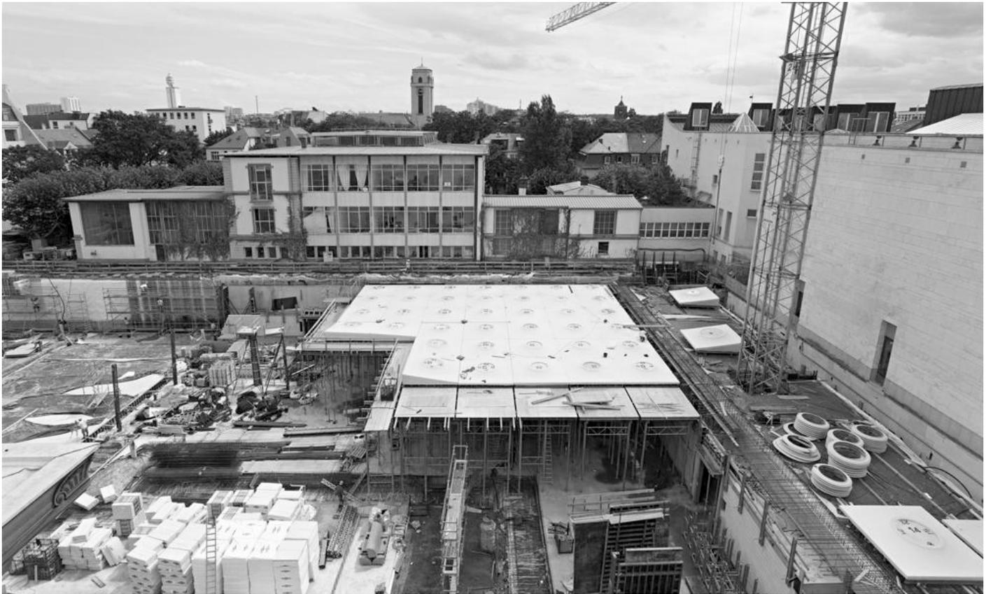
Abb 5 Die Schaltafeln werden auf der Baustelle zusammengesetzt
