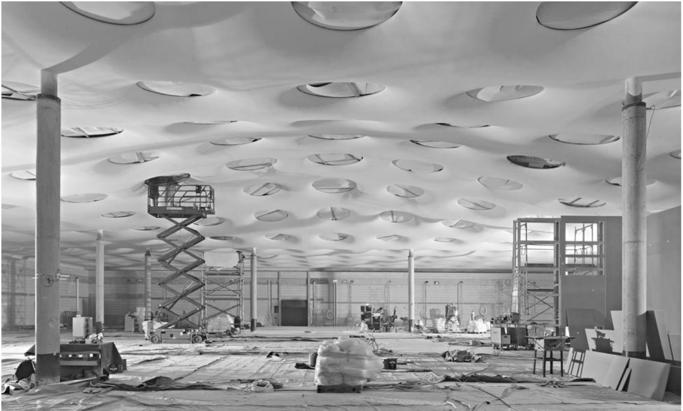
Abb 8 sämtliche Fugen wurden verspachtelt und die Oberfläche gestrichen
