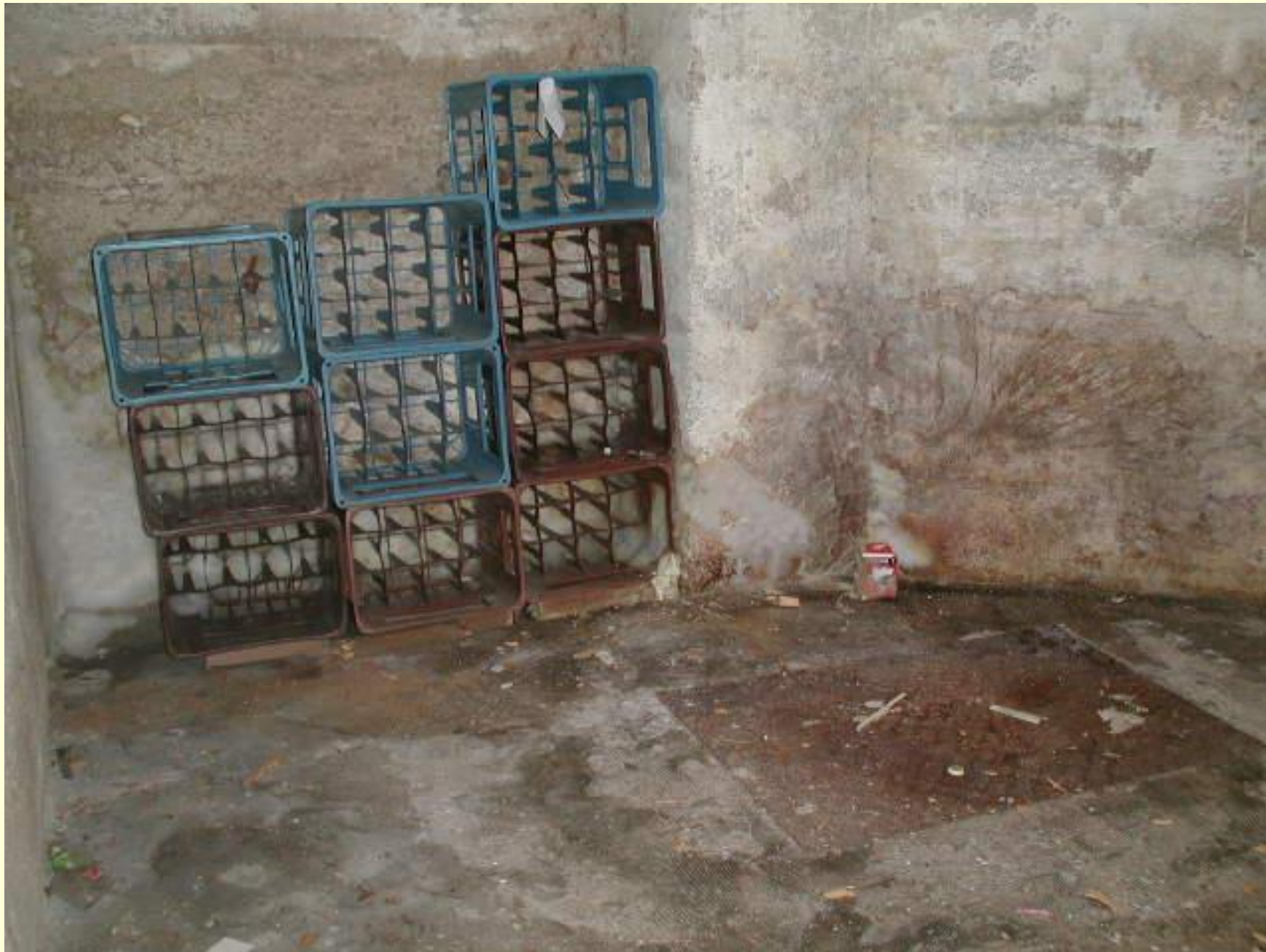
Edmund Bromm Sachverständiger für Feuchte- und Schwammschäden www.denkmal-pflege.de
