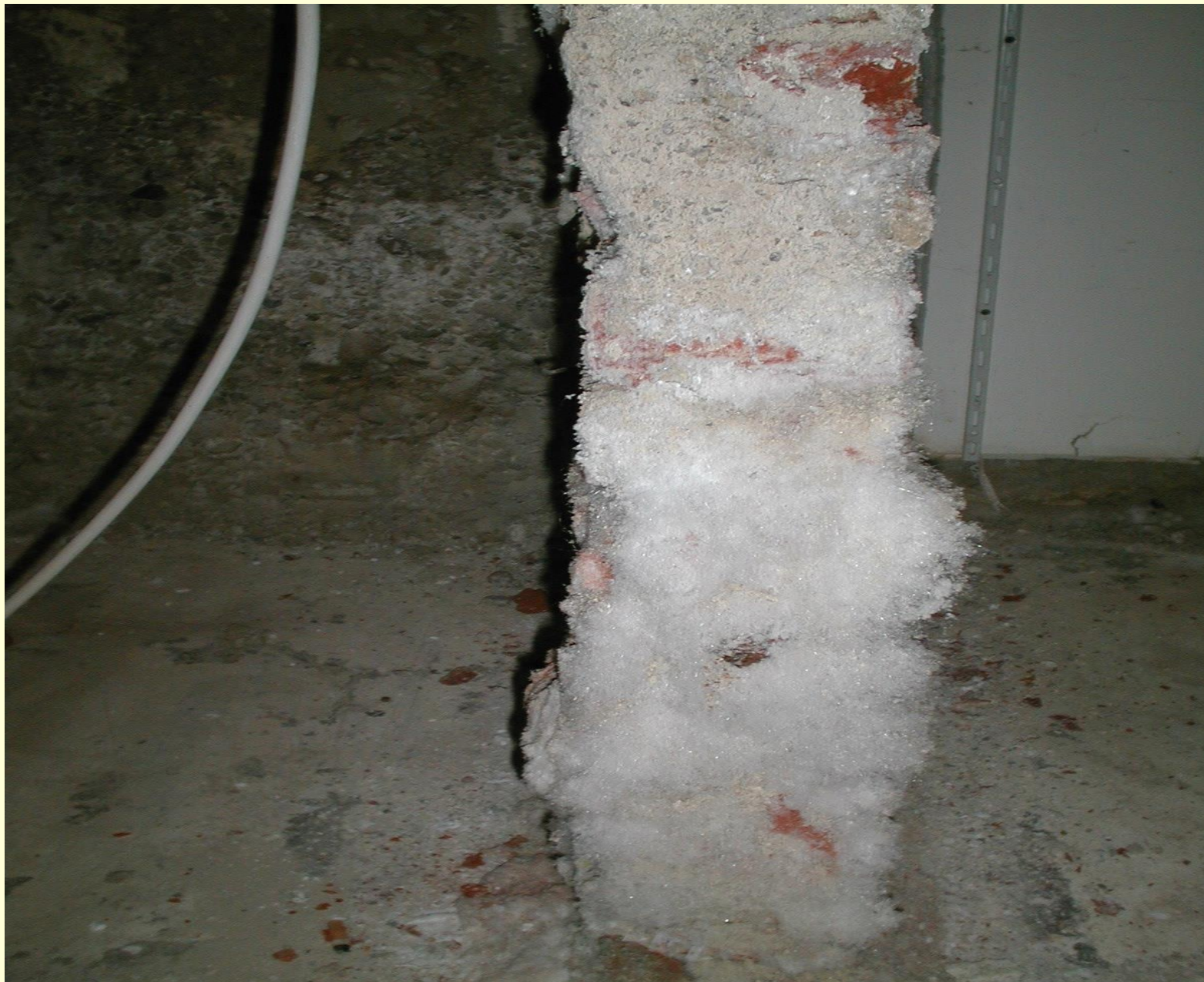
Edmund Bromm Sachverständiger für Feuchte- und Schwammschäden www.denkmal-pflege.de
