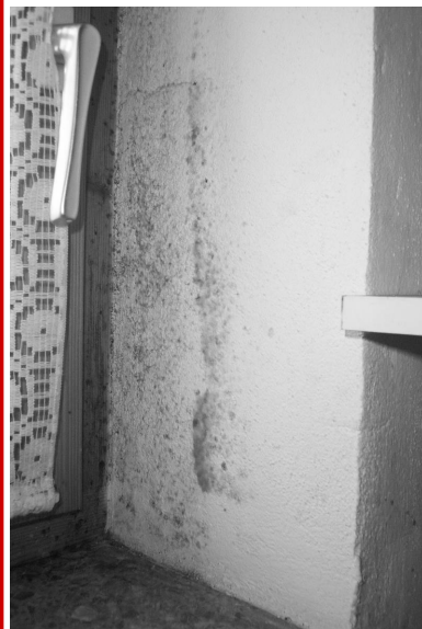
Schimmel durch Wärmebrücken
