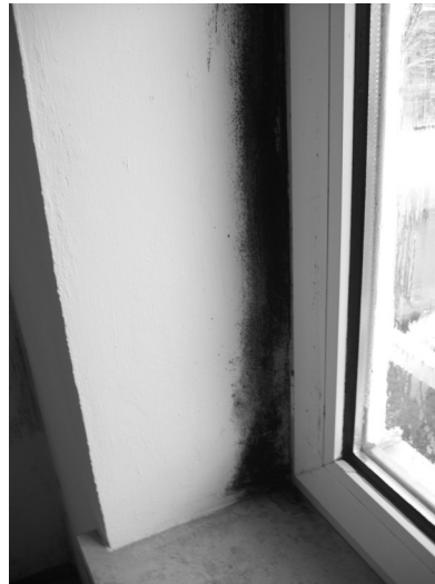
Schimmel durch Wärmebrücken
