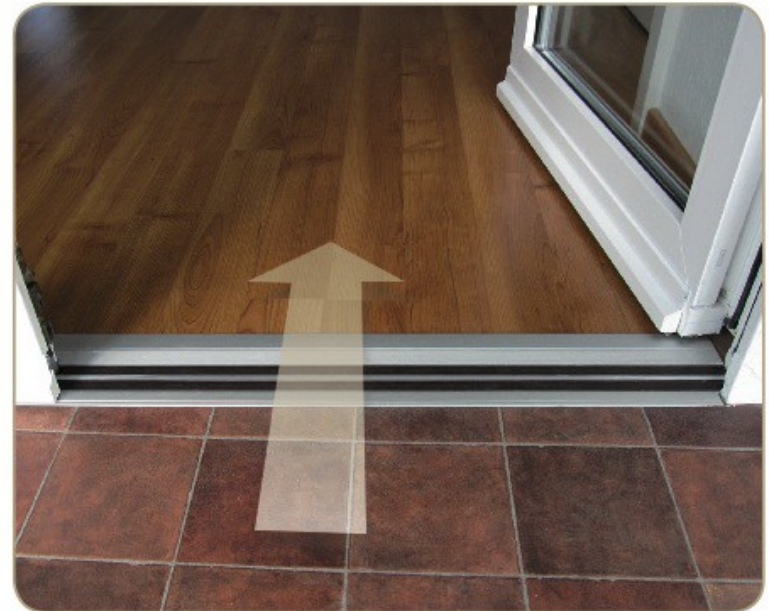
Nachher Barrierefreier Übergang dank Magnet-Doppeldichtung
