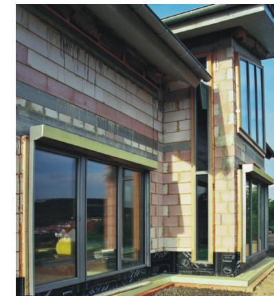
Montage Fenster mit Sonnenschutz im Rohbau
