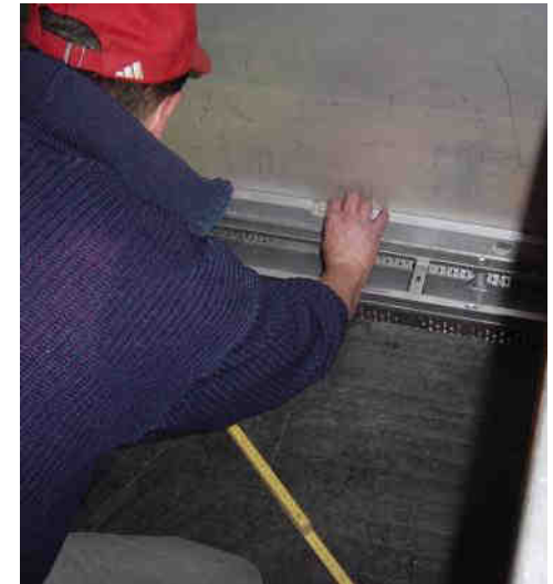
Verwendung einer Flächendrainage - Drainmatte
