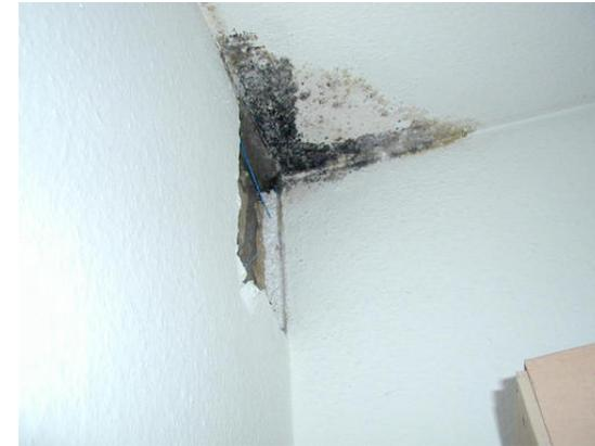
Neubau der Fenster → geschlossene Fugen → Erhöhung der Raumfeuchte
