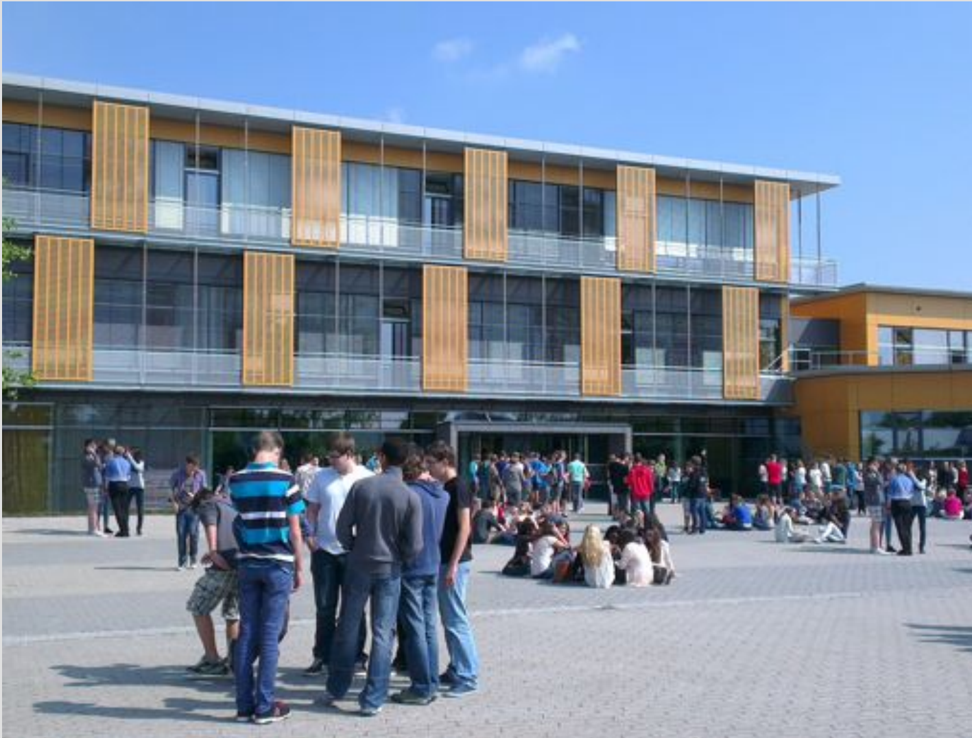
Generalsanierung einer Realschule in Ansbach mit Aufstockung in Holzbauweise
