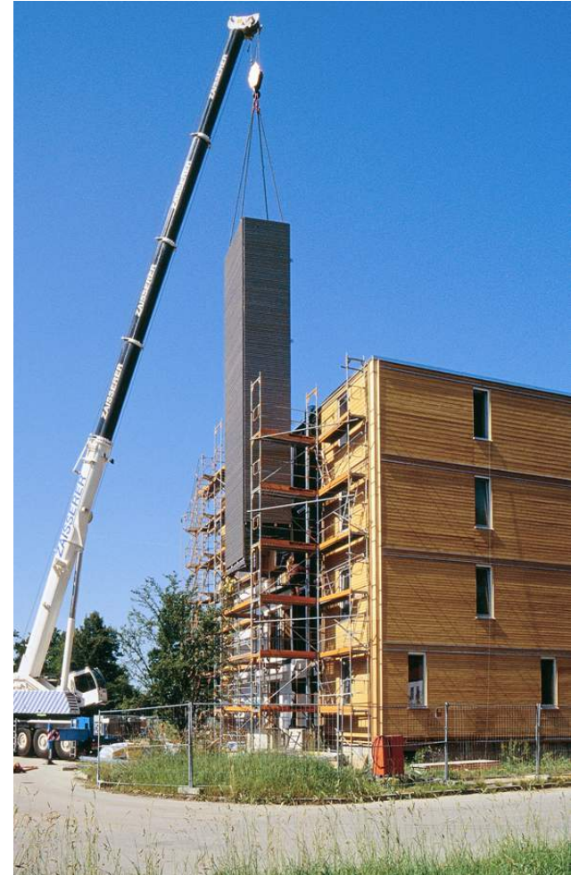
Montage des Aufzugschacht
