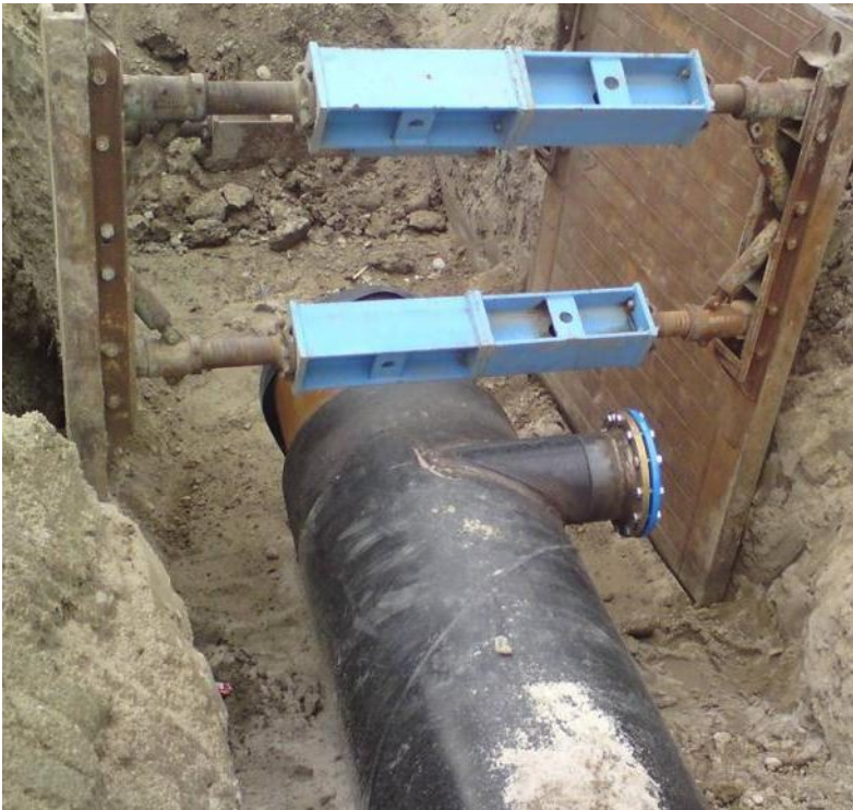
Anschluss Nahwärmetrasse
