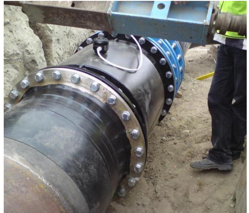
Induktive Durchflussmengenmessung
