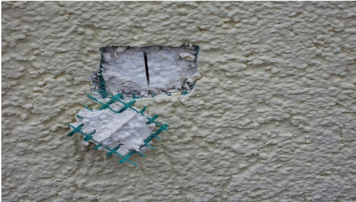
Armierungsmörtel in der Fuge
