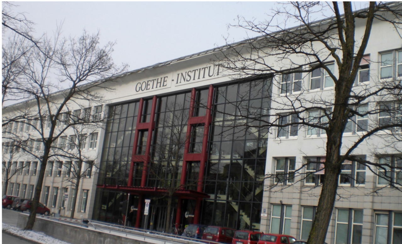
Goethe-Institut, Dachauer Str., München Baujahr 1993 mineralisches System
