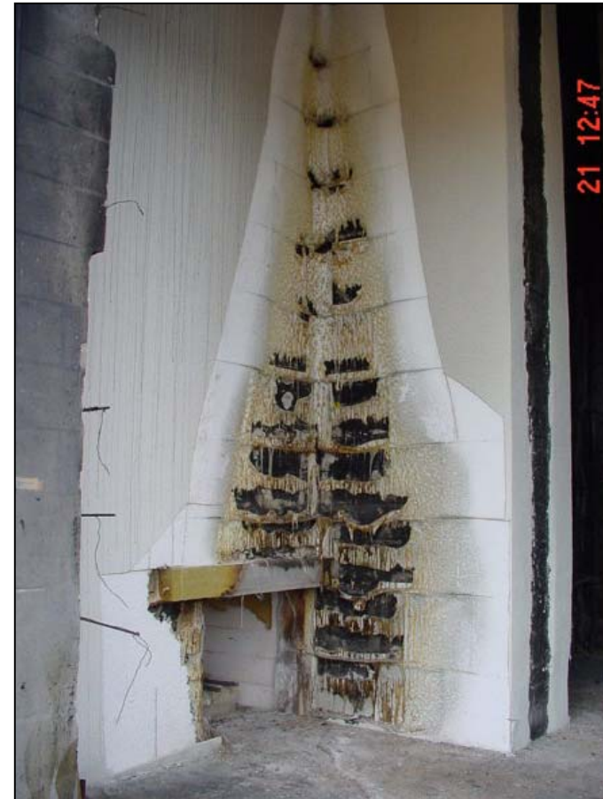
Dämmung nach der Prüfung (Putz entfernt)
