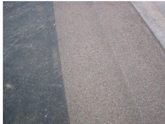
Asphalt strahlen
