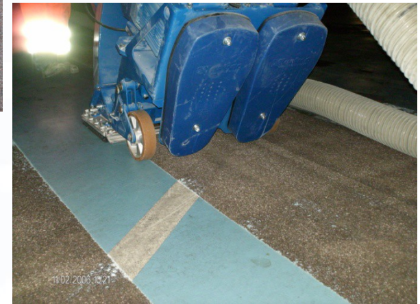
Beschichtung entfernen
