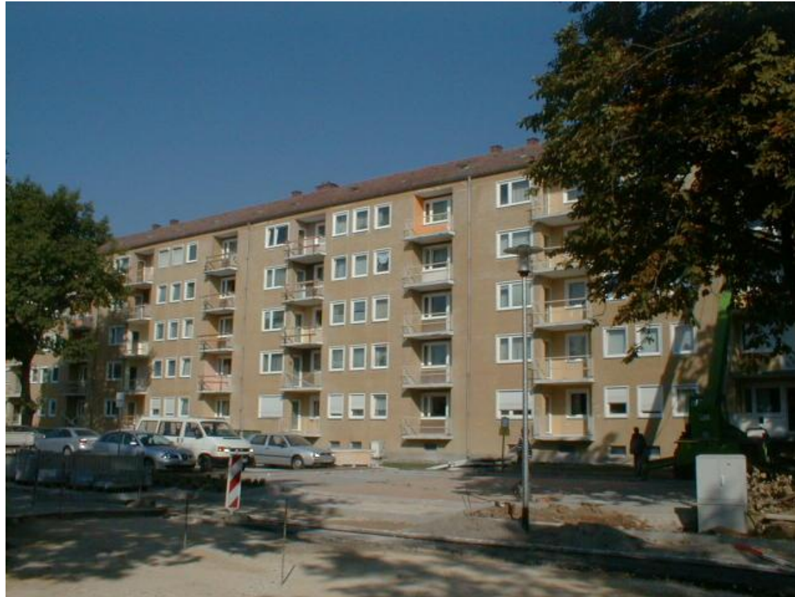
Vor der Instandsetzung
