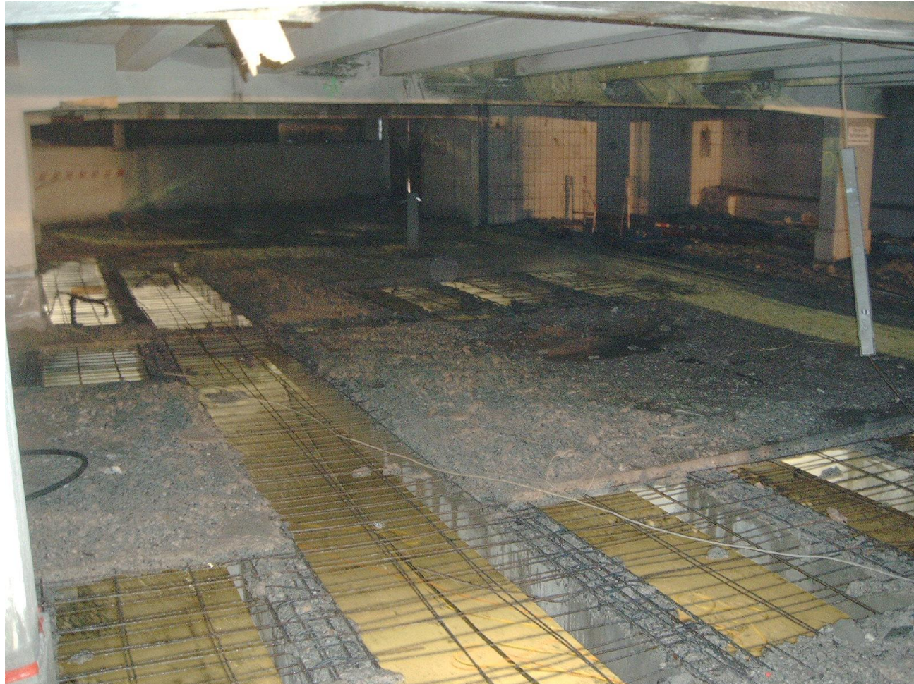
Betonabtrag auf Zwischendecke
