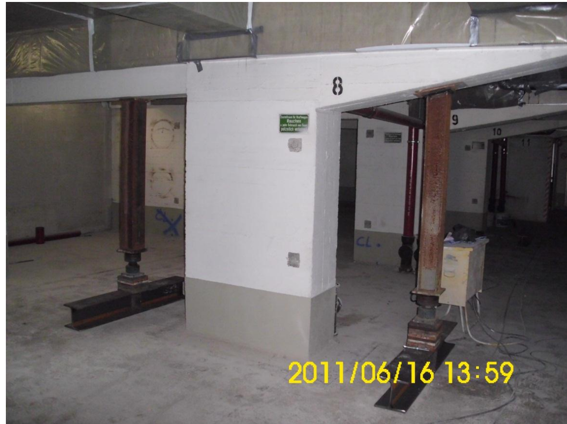
individuelle Abstützungen für Abtrag an Stützen
