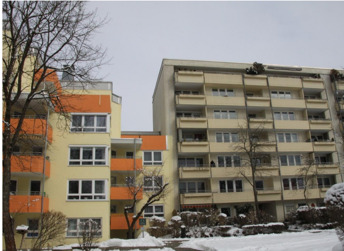
Nach und vor der Instandsetzung
