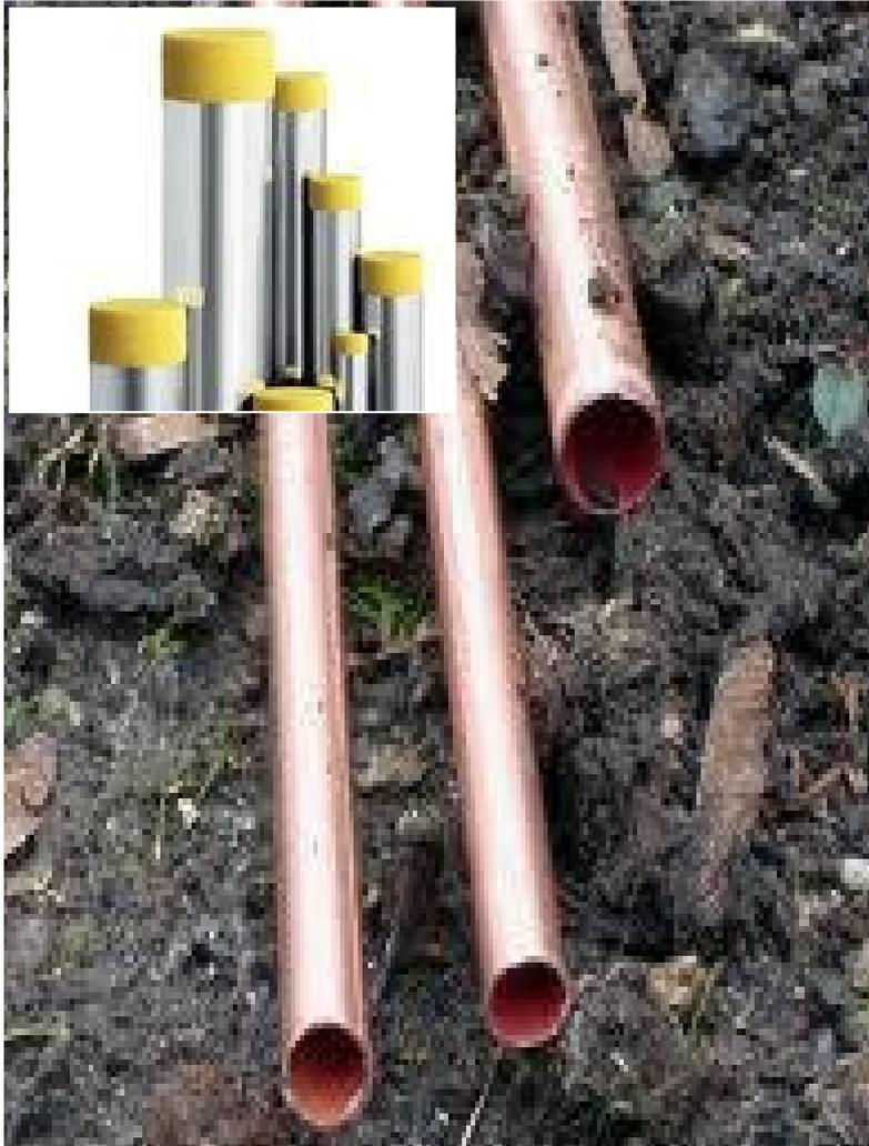
Wasserleitungen müssen in jedem Arbeitsschritt an den Enden verschlossen sein!
