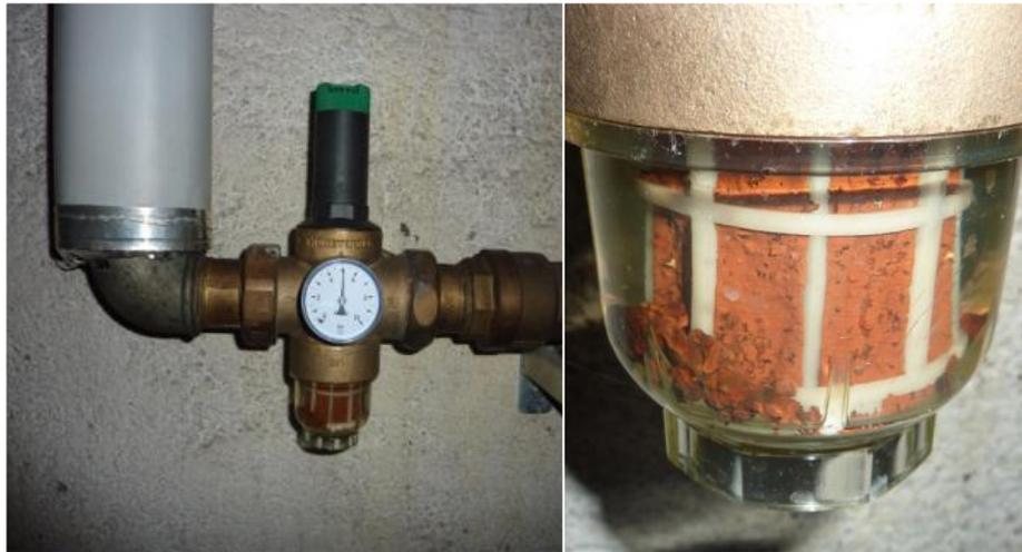
Der Sieb eines Druckminders dient zum Funktionserhalt, wird oft als „Filter“ missbraucht. Die Anordnung sollte in der Fließfolge immer nach den Filter sein.
