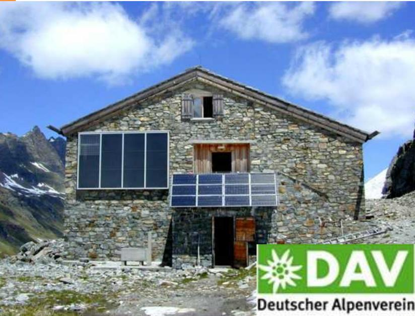
**10 m<sup>2</sup> Autarke Luftkollektoranlage zur Beheizung, Belüftung und Trocknung der stark feuchtebelasteten Räume.**
