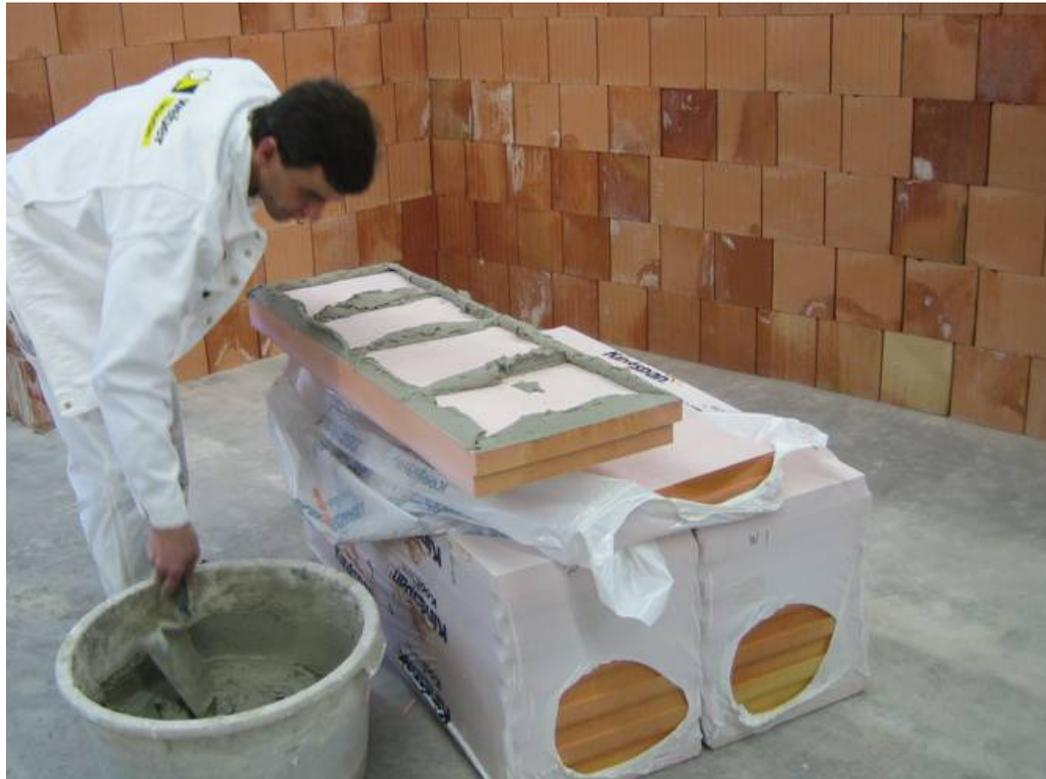
Die Dämmplatte wird rahmenförmig an den Plattenrändern mit drei senkrechten Streifen mit weber.therm plus ultra beschichtet! Hierbei ist eine 60 % Verklebung zu erreichen.
