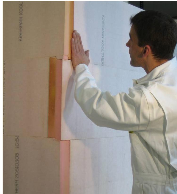
An den Ecken werden die Platten ebenfalls im Verband verlegt.
