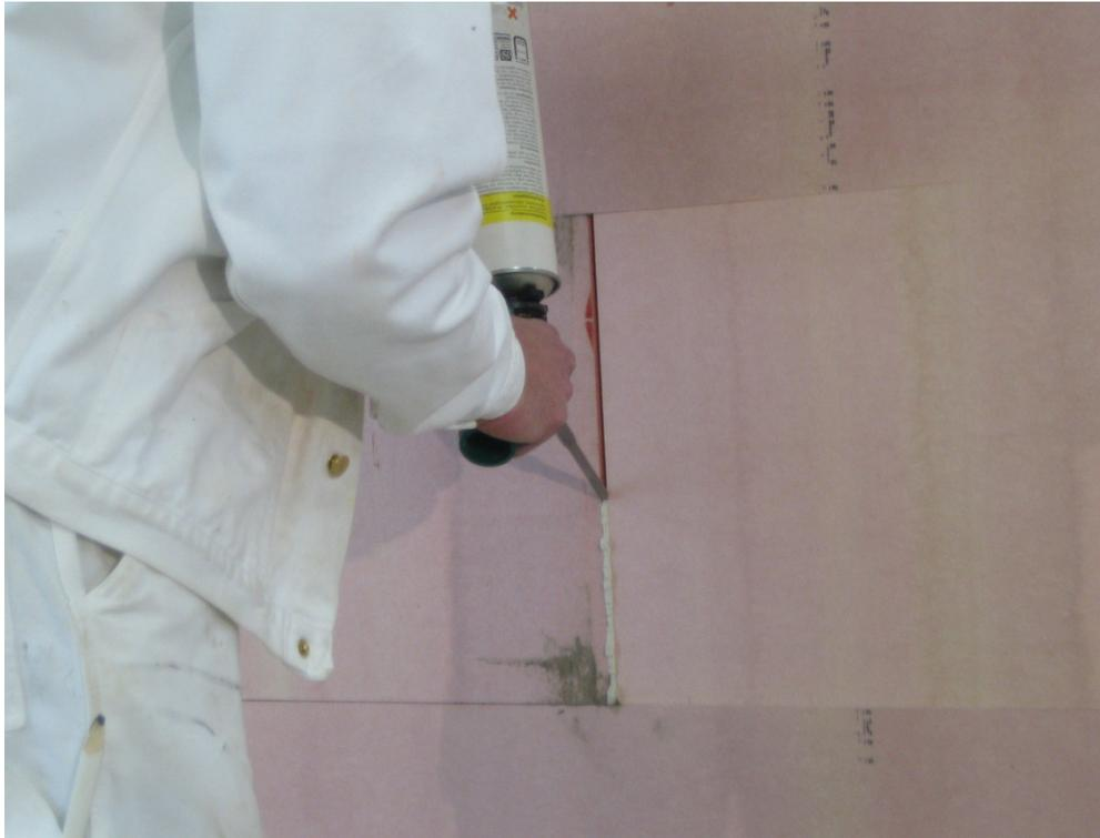
**Kleinere Lücken (bis 10mm) können mit dem B1 Füllschaum weber.therm 345 ausgeschäumt werden (Lücke 0,5 bis 1,0 cm V-förmig aufweiten).**
