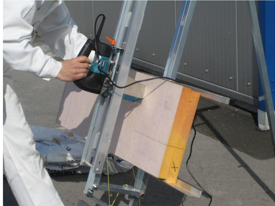
Die weber.therm 022 plus ultra Platten können mit einem Sägeschneidgerät komfortabel geschnitten werden. Details können leicht und sauber ausgearbeitet werden.
