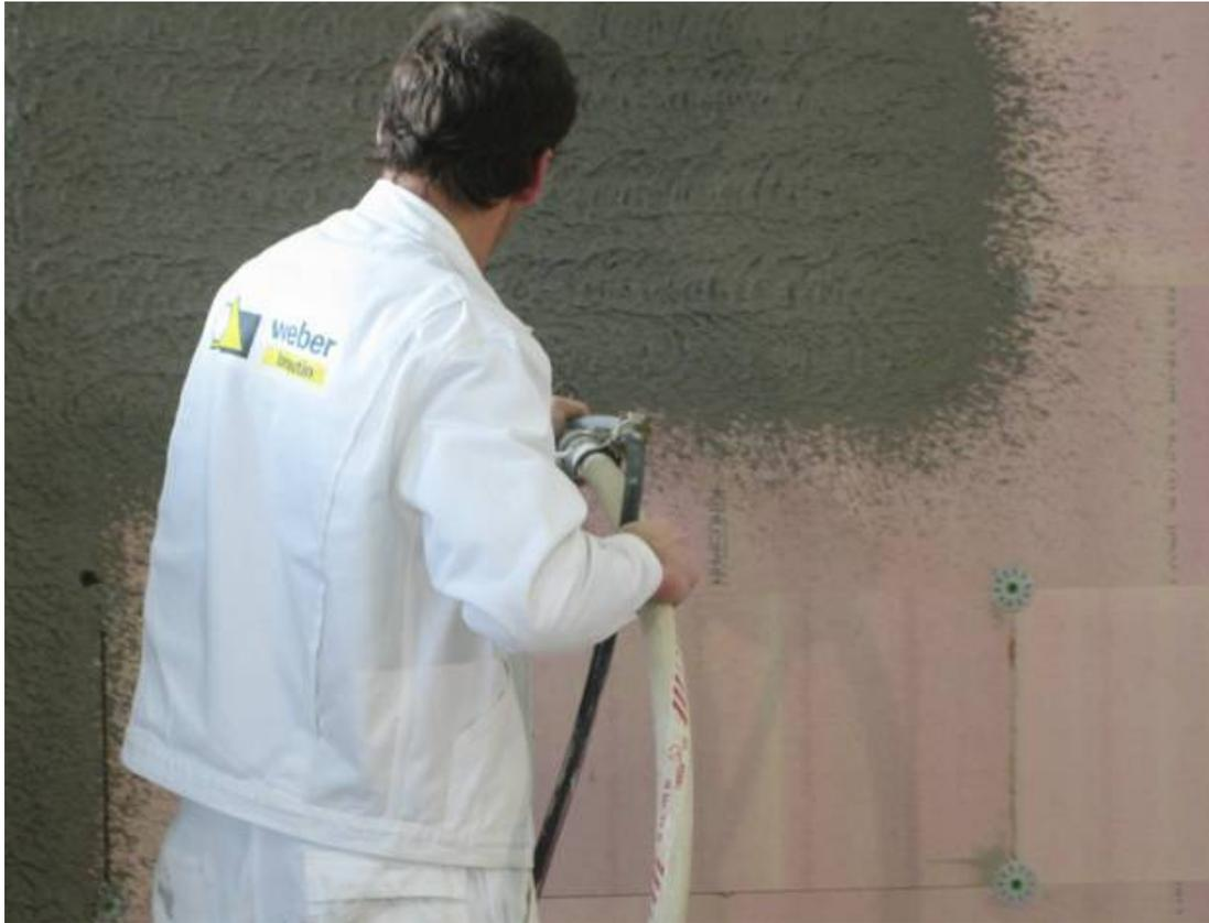
**weber.therm plus ultra wird ca. 5-7 mm dick auf die Dämmplatten aufgetragen und plangezogen.**
