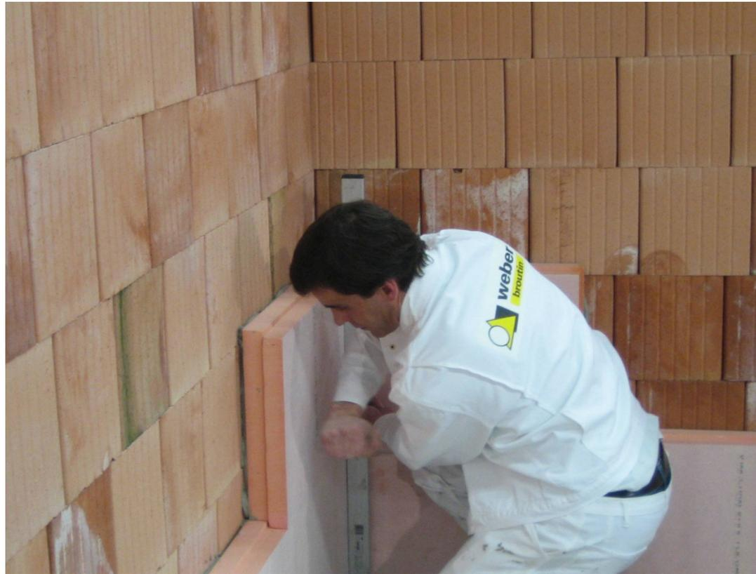
**Exaktes Ausrichten der ersten Dämmstofflage ist für ein fugenloses Verlegebild unerlässlich.**
