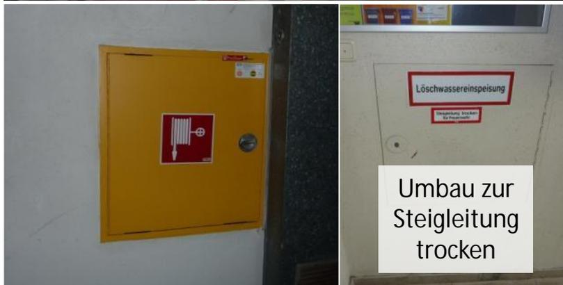
Die Rohrleitungen von Feuerlöscheinrichtungen sind für den Wasserdurchsatz im Brandfall ausgelegt, im Normalfall werden diese nicht durchströmt.
