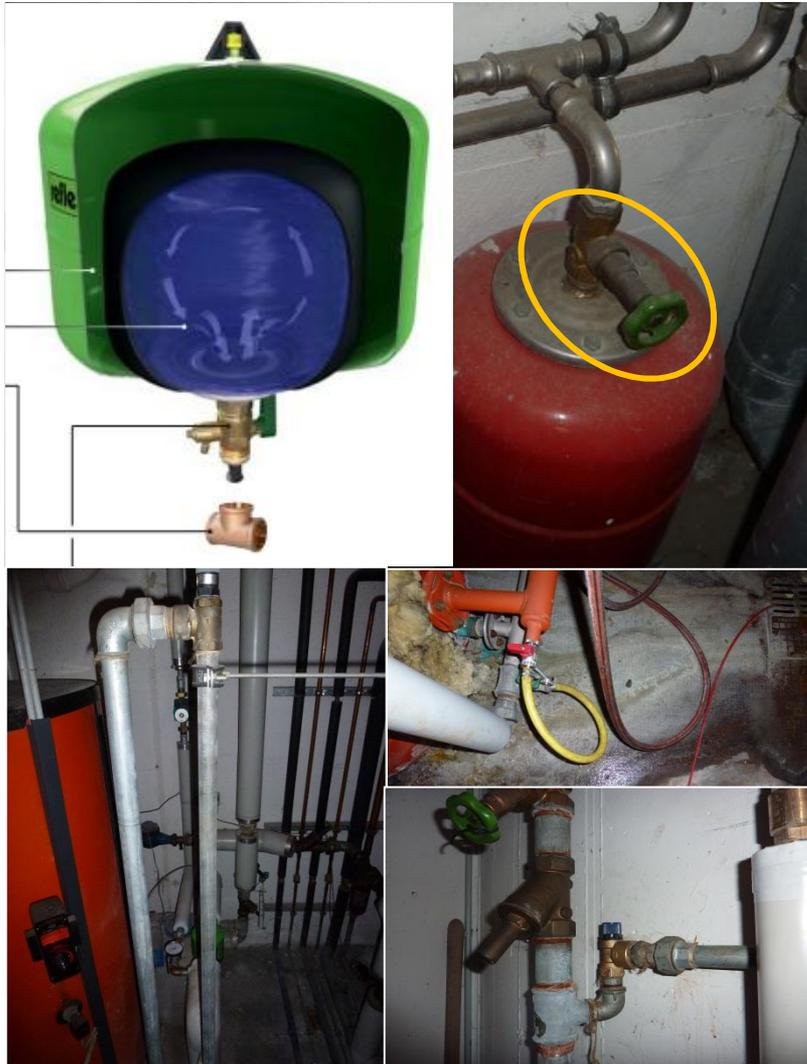
Ausdehnungsgefäße sollen Druckschwankungen ausgleichen, werden sie nicht durchströmt, wird z.B. bei einer Störung das gesamte zuvor „angekeimte“ Wasser in das Trinkwassernetz abgegeben.
