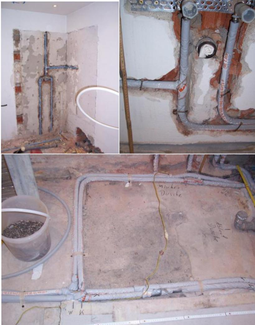
Kalt- und Warmwasserleitungen müssen ausreichend gedämmt sein, um thermische Einflüsse und Wärmeverluste des Mediums zu vermeiden.
