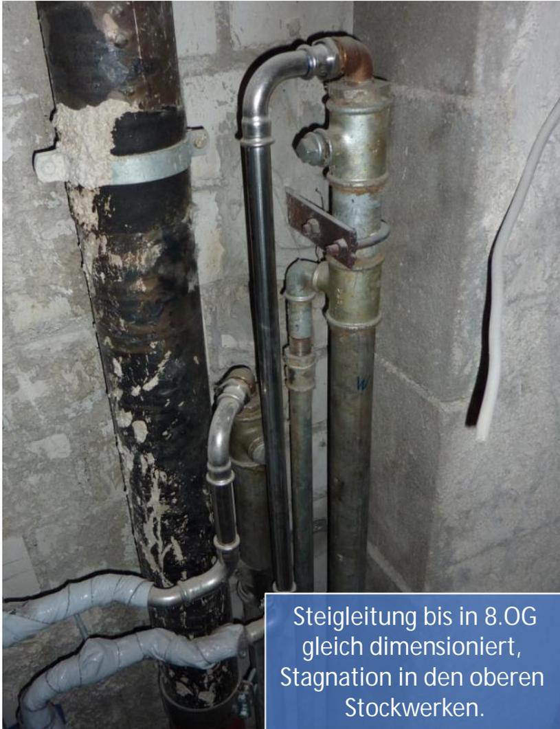
Frühere Systeme wurden mit Sicherheitszuschlägen und großzügigen Gleichzeitigkeitsfaktoren ausgelegt, viele der früher angeschlossenen Verbraucher z.B. Druckspüler hatten einen hohen Wasserverbrauch.
