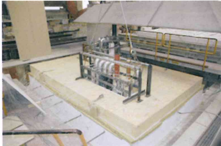
Bild 10: Prüfung eines Deckenschotts zum Einsatz in hochfeuerhemmenden Deckenkonstruktionen in Holzbauweise für die Gebäudeklasse 4
