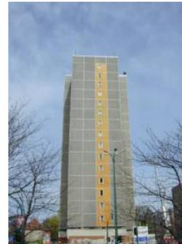
Im Zuge der Fassadenrenovierung wurde im Jahr 2000 eine Solar-Luft-Fassade zur Erwärmung der Frischluft für die innenliegenden Nasszellen eingebaut. Sommernutzung zur Warmwasserbereitung
