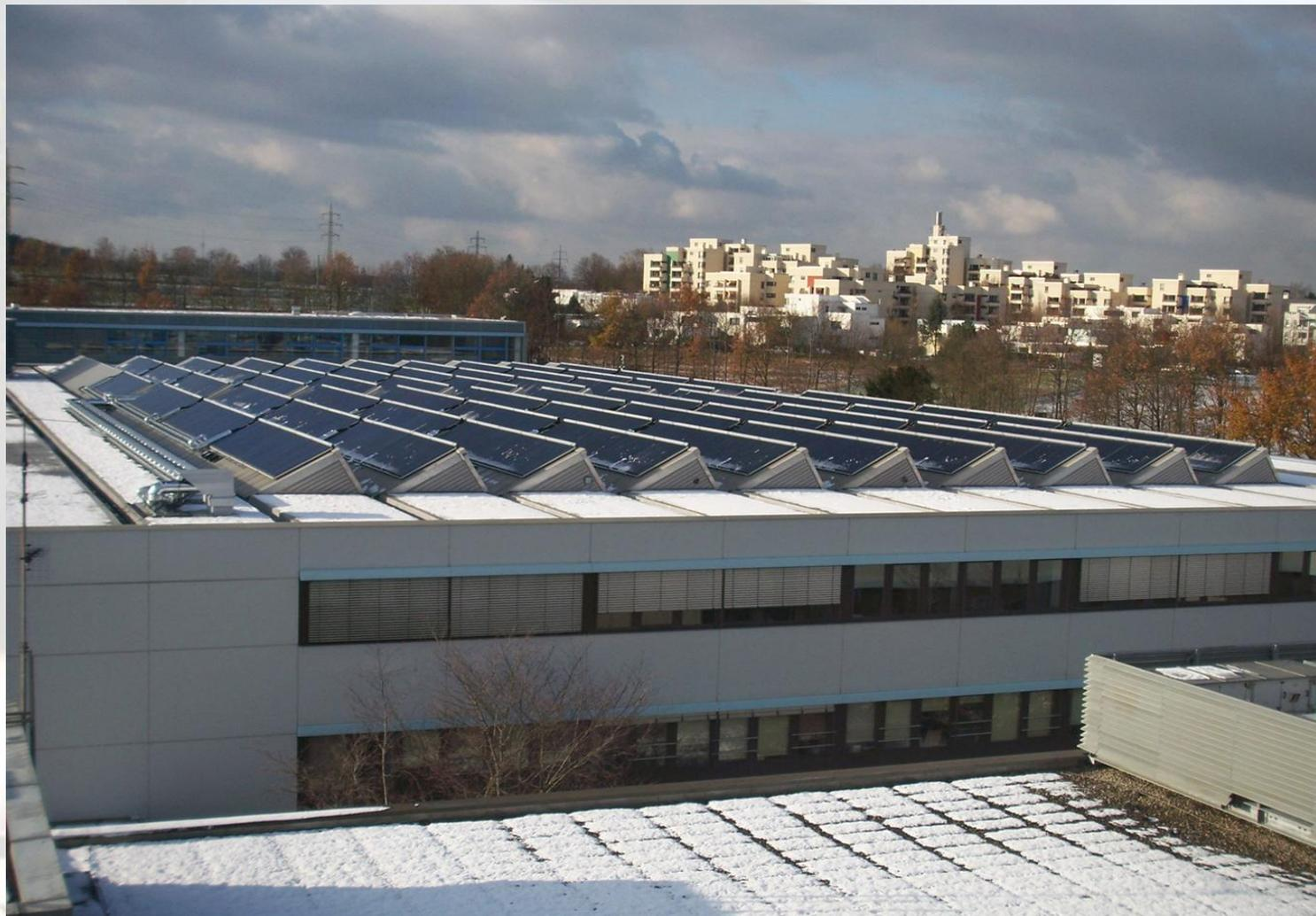
Vakuurröhrenkollektoranlage bei Festo AG & Co. KG in Esslingen
