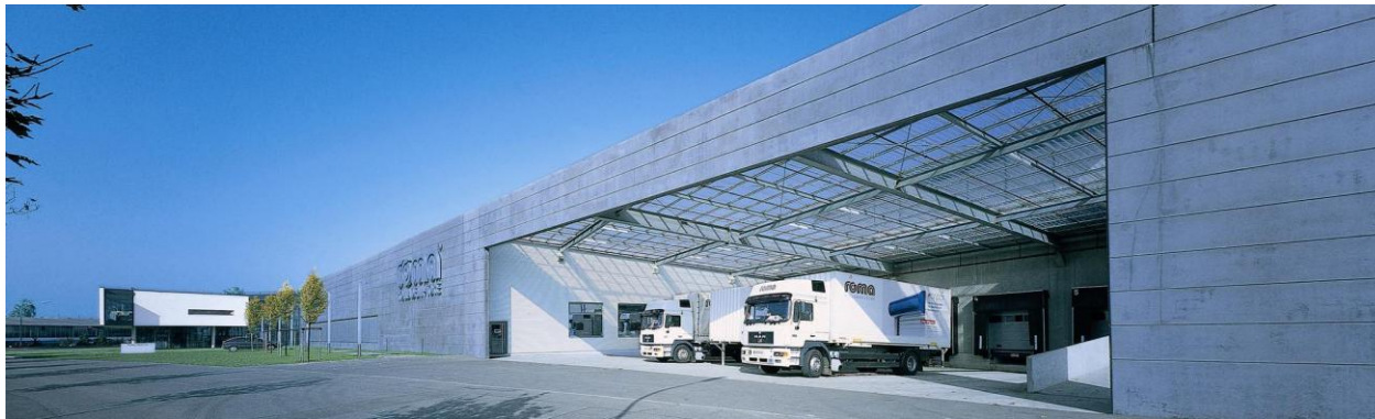
Werk Burgau heute Ansicht Südwest
