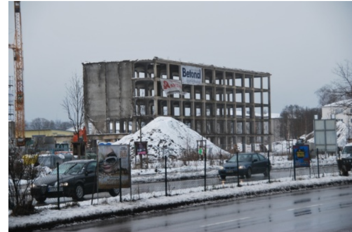
Hieraus entsteht ein Seniorenwohnheim
