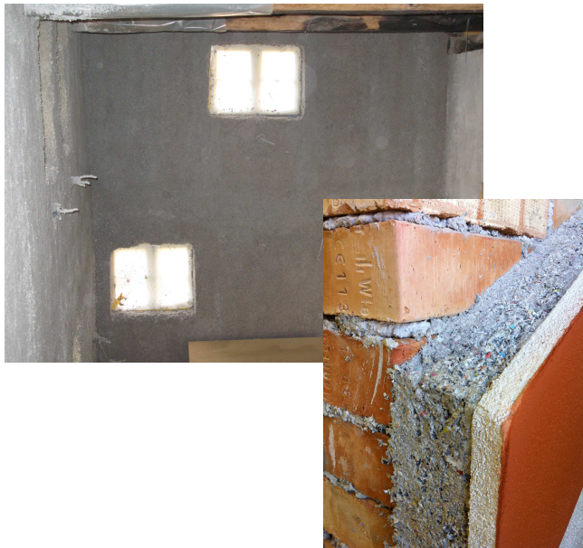
Climacell® "Inside" gesprühte Kapillaraktive, verputzte Innendämmung
