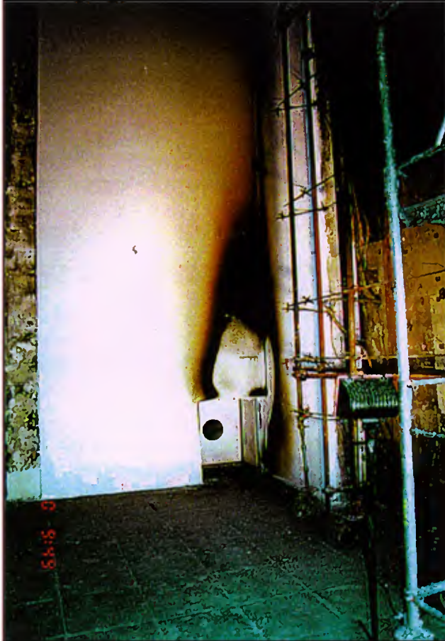
100 mm EPS nach der Prüfung, mit Putzschicht, ohne Brandsperre
