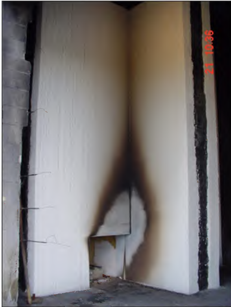
200 mm EPS 15 nach dem Versuch, mit Putzschicht
