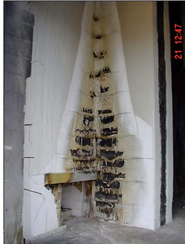
200 mm EPS 15 Putz entfernt, Dämmung
