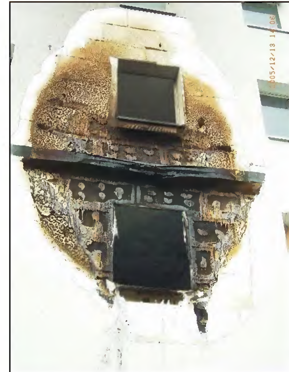
Dämmung nach dem Entfernen des Putzsystems
