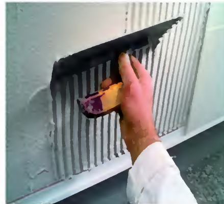
Vollflächiger Kleberauftrag auf die Wand
