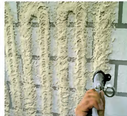
Teilflächiger Kleberauftrag auf die Wand mittels Maschine
