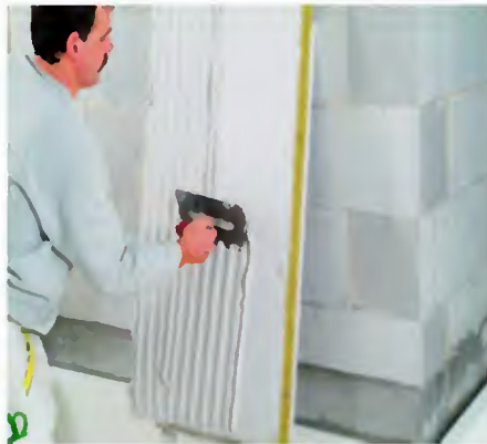
Vollflächiger Kleberauftrag auf die Dämmplatten-Rückseite
