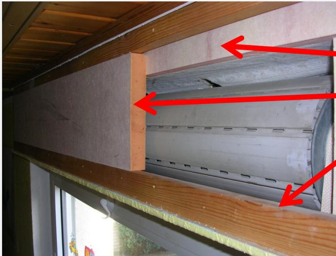
Hochleistungsdämmstoff WLG 022,
