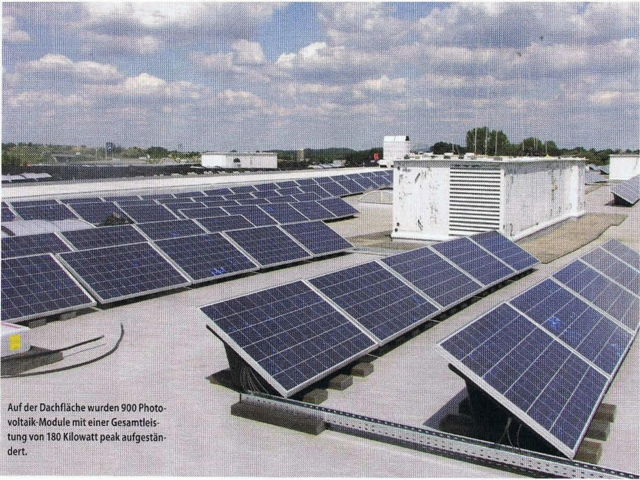
Auf der Dachfläche wurden 900 Photovoltaik-Module mit einer Gesamtleistung von 180 Kilowatt peak aufgeständert.
