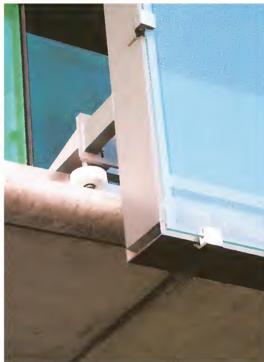
Detail zeigt die Glas-/ Modulaufnahme
