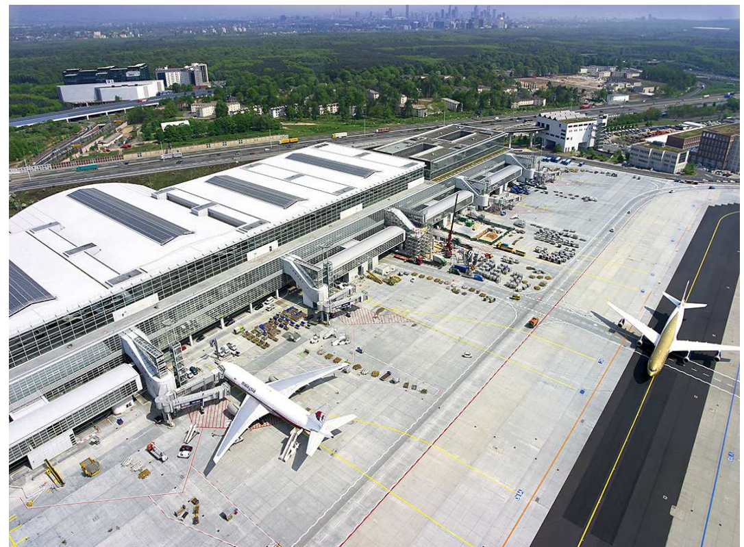
Terminal 2 Ffm Bestandsgebäude
